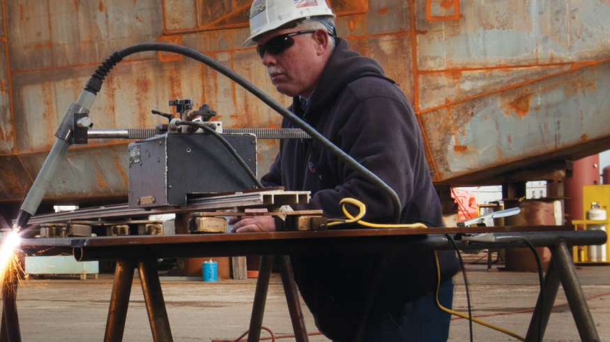
Резка и строжка по направляющей
